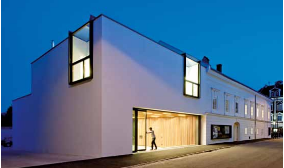
Offenes Amtshaus Ottensheim, Oberösterreich, als gelungenes Beispiel für den Umgang mit und Ergänzung von bestehender Bausubstanz, ausgezeichnet mit dem Bauherrenpreis 2010 (SUE Architekten, 2010)
